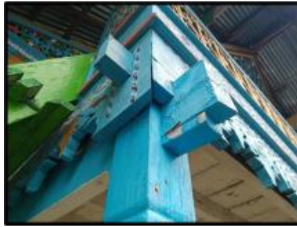
Gambar 4. Peulangan/Tempat bertumpu dinding
