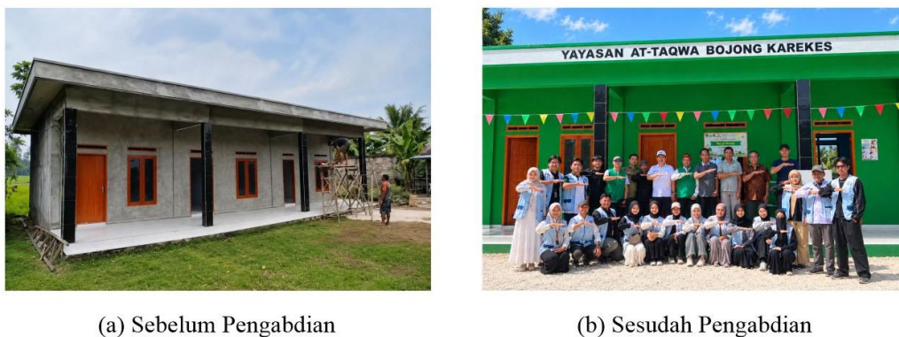
Gambar 5. Kondisi Gedung dan Halaman RA Sebelum dan Sesudah Pengabdian
