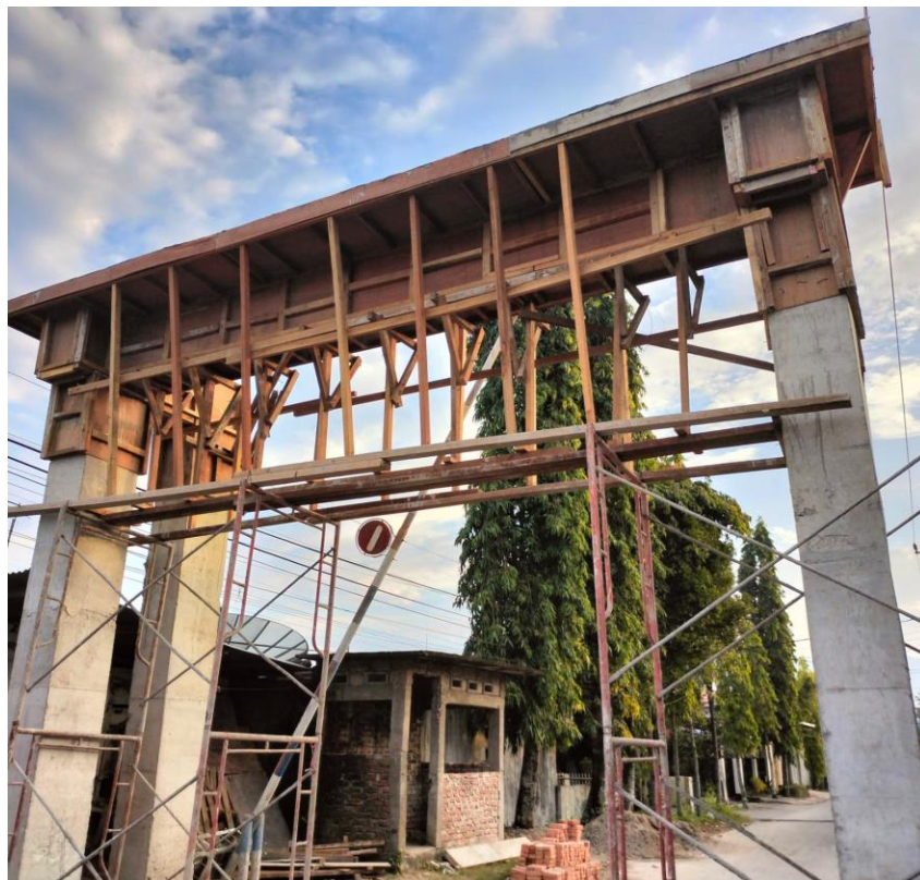
Gambar 2 proses pembangunan Gapura Pintu Masuk Di Jalan Handayani RW 14 Kota Padang
